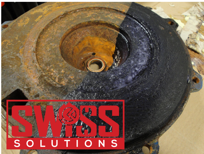
Zichtbare verandering van roest naar een metaalcomplex (kwast)
