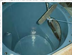
Filtre à eau de mer enduit
