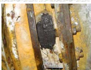
Après chauffage, l'application est terminée
