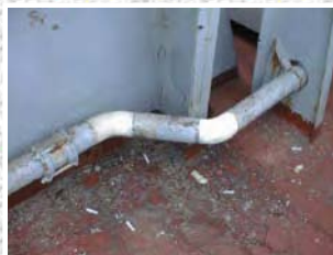
Fuites réparées avec Wencon Pipe Tape
