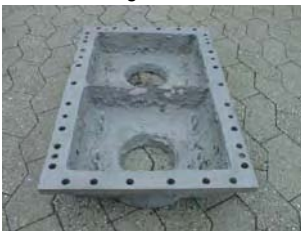
Capot de protection corrodé
