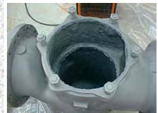
Filtre à eau de mer corrodé
