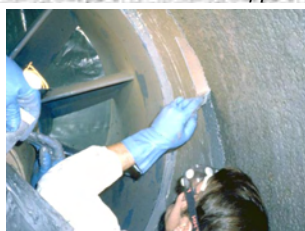
Reparatur einer korrodierten Pumpe
